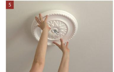
Sorgen Sie für einen sauberen, trockenen und glatten Untergrund. Richten Sie die Rosette auf die richtige Position aus und drücken Sie sie fest an. Entfernen Sie mögliche Kleberreste mit einem feuchten Lappen. Die umlaufende Fuge können Sie mit Maleracryl füllen.
