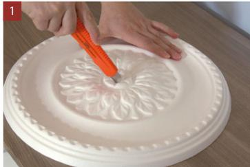
Bei der Nutzung als Lampenrosette schneiden oder bohren Sie einen passenden Kabelauslass heraus.
